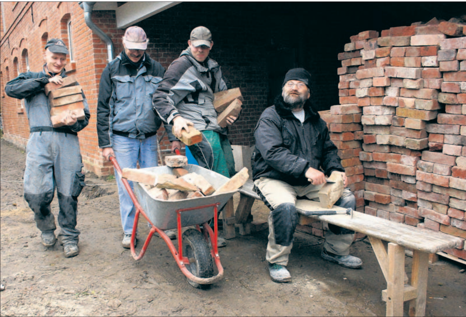
Sie klopfen Steine und bauen die Hofanlage Saalkow mit auf (v.l.): Stefan Löskow, Joachim Göttner, Florian Hensel und Friedbert Bröcker. Der Verein hat das Grundstück bei einer Nachlassversteigerung erworben. Hier entstehen Wohnungen und eine Mensa.
